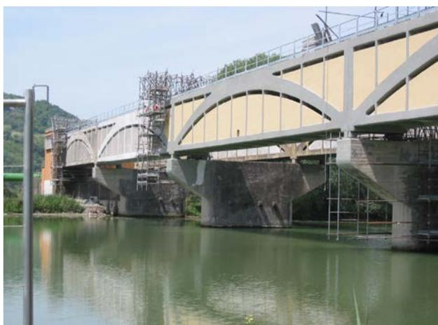
Per interventi di spessore 3 – 5 cm MasterEmaco S 488 deve essere utilizzato solo previa applicazione di rete elettrosaldata; per interventi di tale spessore si consiglia tuttavia l'utilizzo di MasterEmaco S 488 FIBER.
